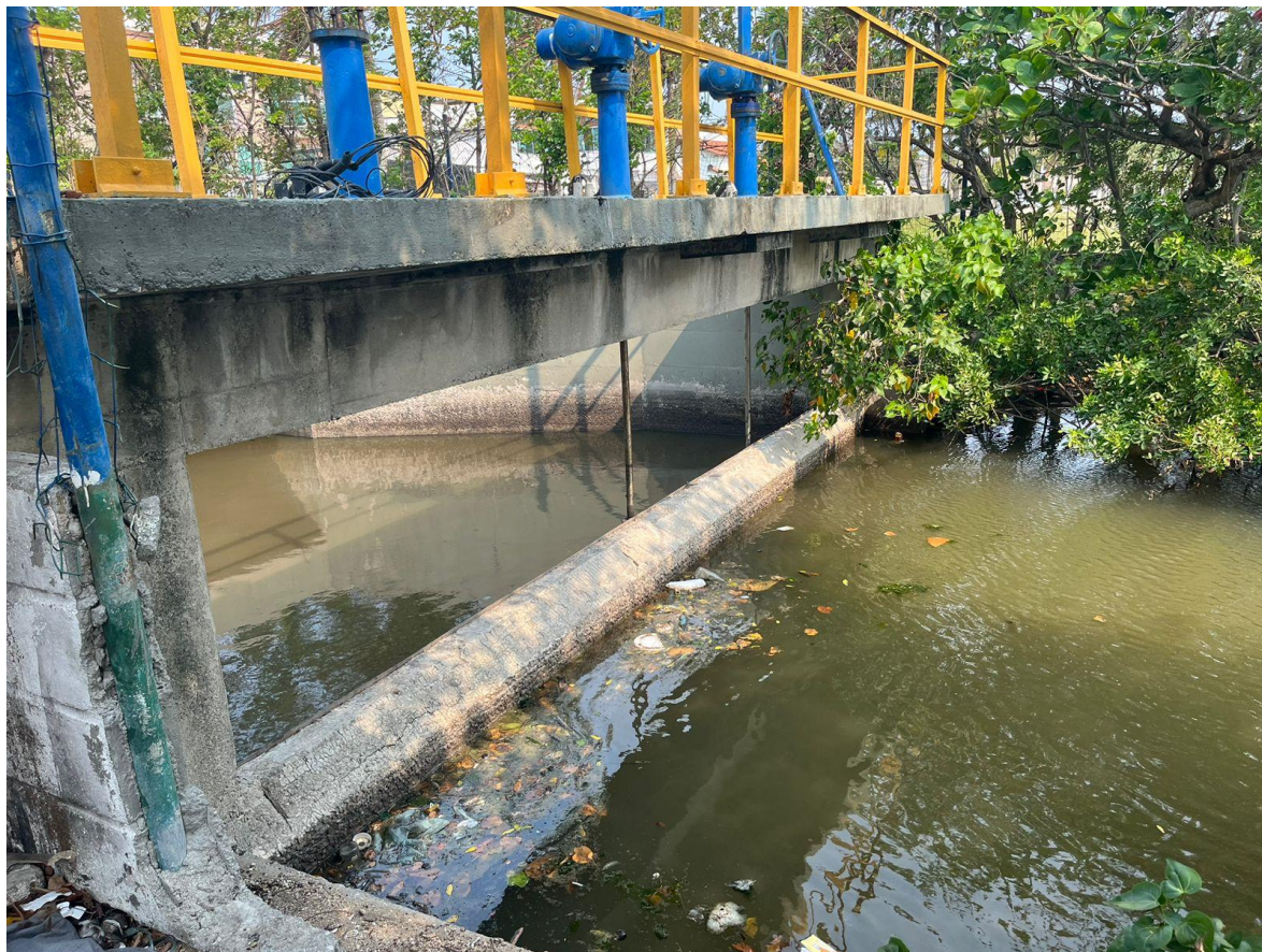
Figura 88 - Canal do Redesvio.
