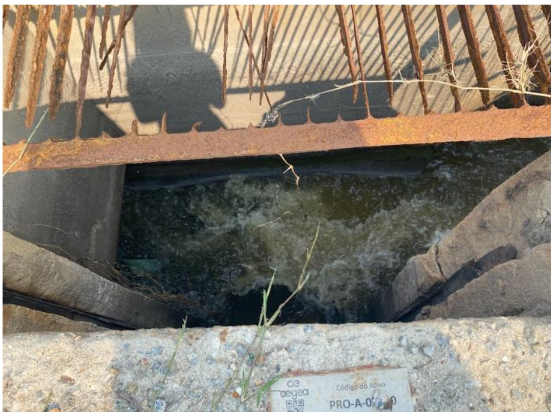
Figura 90 - Entrada da EEE Siqueira I.
