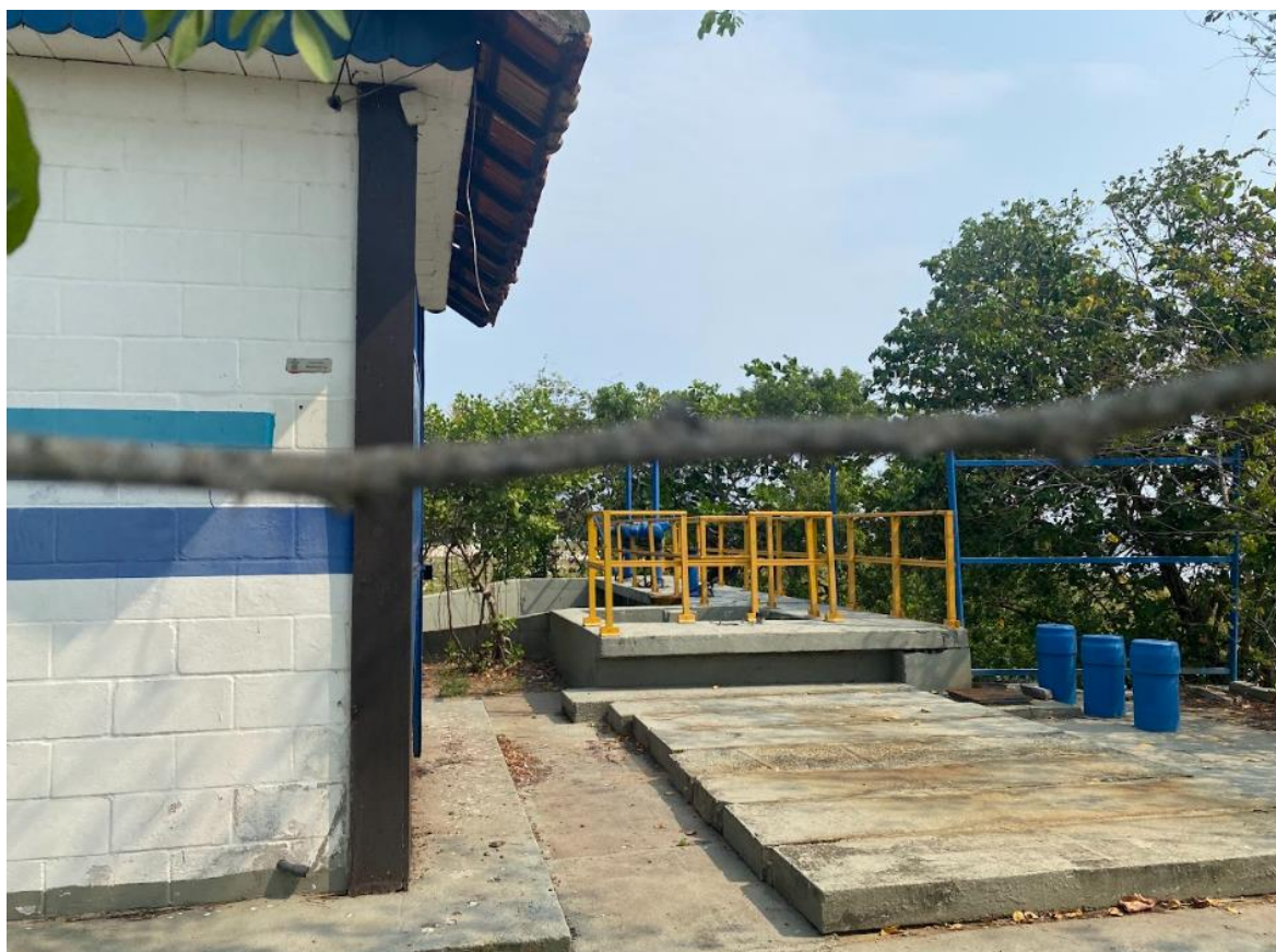
Figura 89 - Área da comporta do canal do Redesvio.
